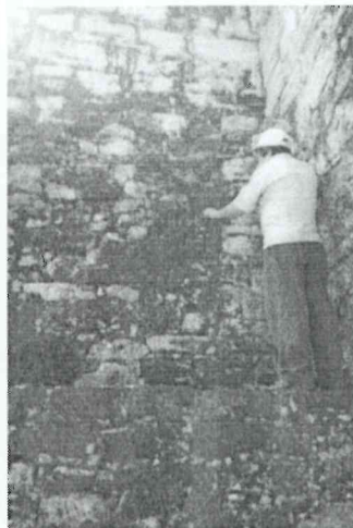
Foto 12. Trabajos de limpieza en el Edificio C, Topoxte
