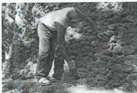
Foto 3. Edificio 375, limpieza de fachada
