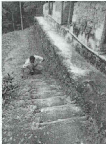
Foto 1. Trabajos de limpieza y chapeo, Edificio 217
