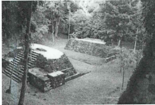
Foto 7. Juego de Pelota 1 luego de los trabajos de conservación
